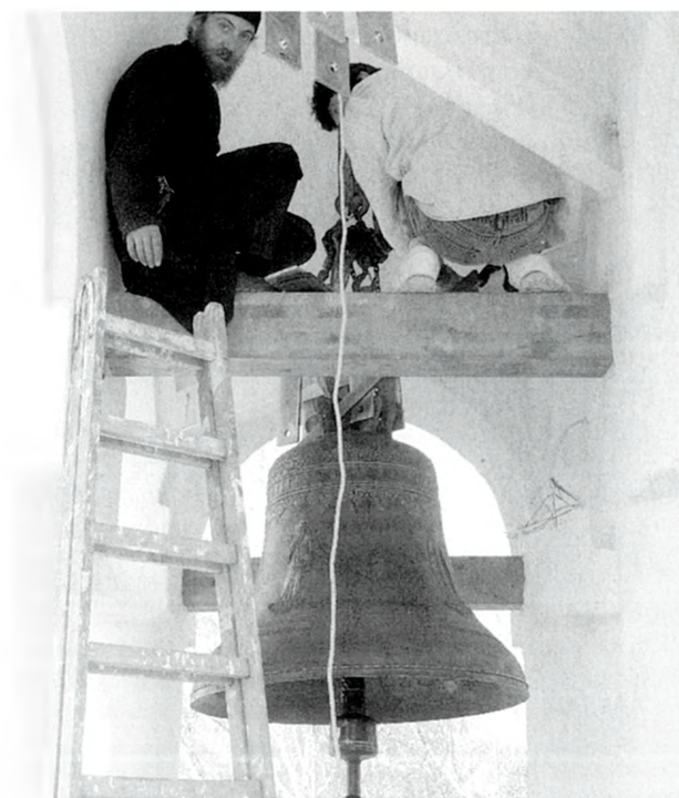
Инок Георгий и трудник Валерий закрепляют колокол на балке звонницы.
