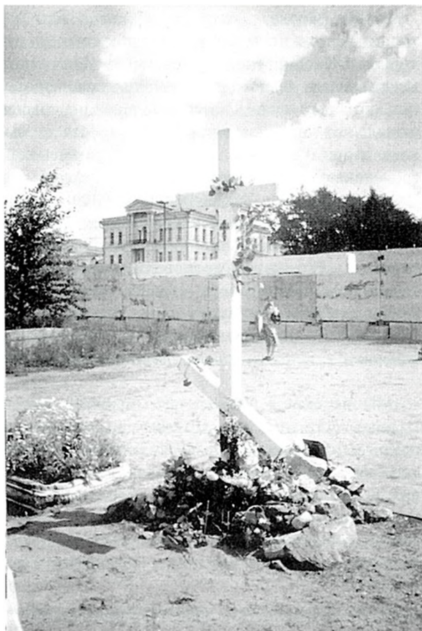
Крест у западной стены снесенного Ипатьевского дома.
