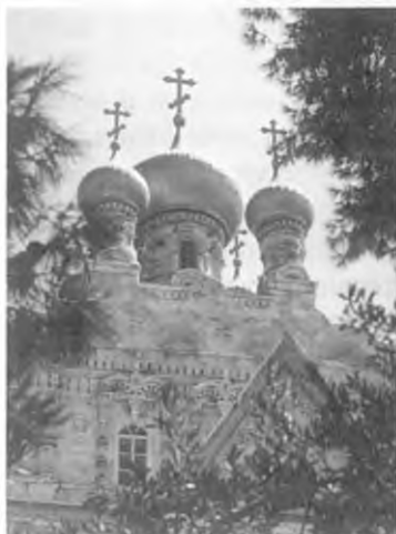
Церковь Святой Марии Магдалины находится под угрозой разрушения.
